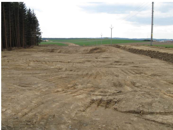
Obr.1 – Terénní deprese před skrývkou, pohled od severu
