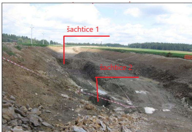
Obr.2 – Severní partie se šachticemi 1 a 2, pohled od jihu
